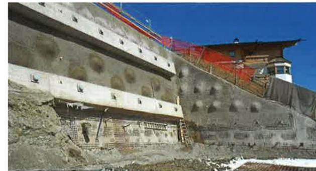
Ein Großteil des Einschnitts wurde durch eine verankerte Spritzbetonschale gesichert.
